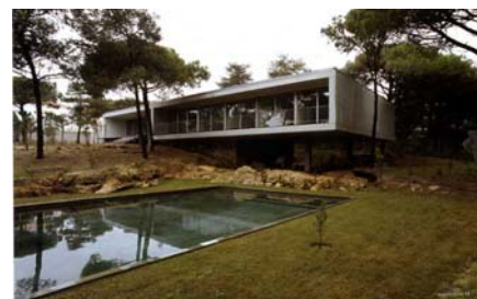
Vivienda en Cascais, 2002
